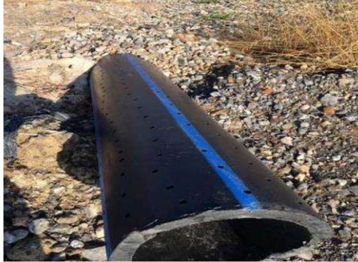
Görsel 7. Sızıntı Suyu Drenaj Sistemi
