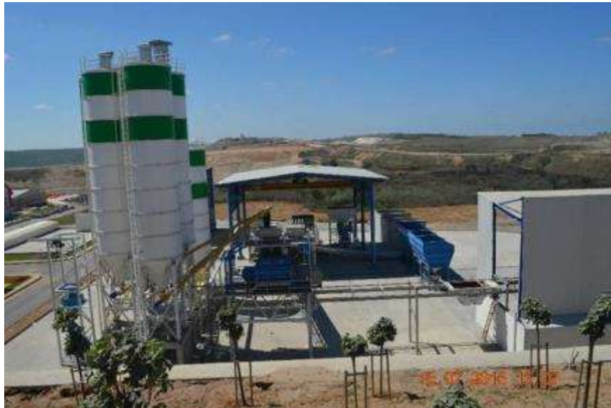
Görsel 5. S/S Tesisi
